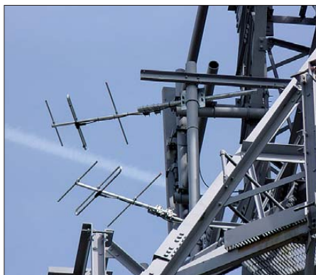
Die zwei Yagi-Antennen der Bake sind nach 288° und 348° ausgerichtet; sie überstreichen somit einen großen Teil der Britischen Inseln.
