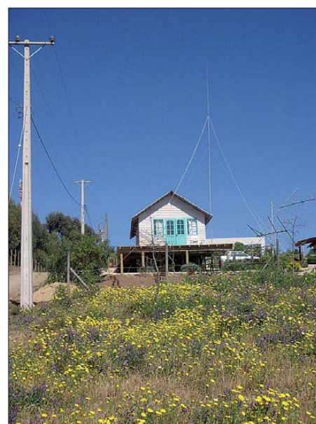
Bild 11: Das gemietete Haus mit den Antennen, links die störende Freileitung
